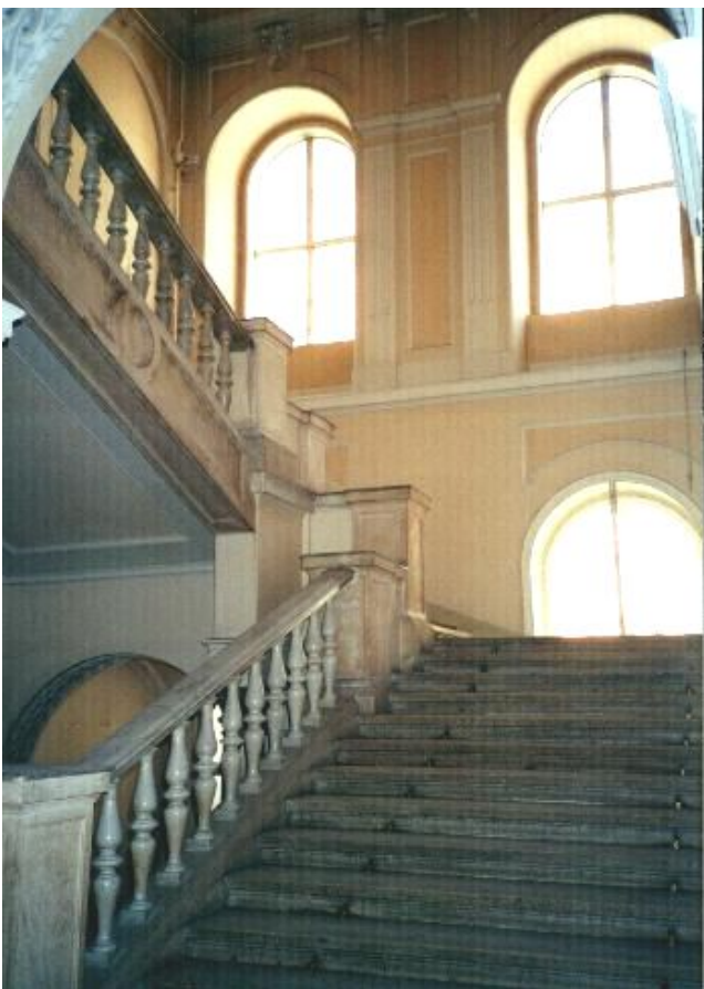
Großes, ursprünglich dreistöckiges, später aufgestocktes (1951/52) Amtsgebäude mit
