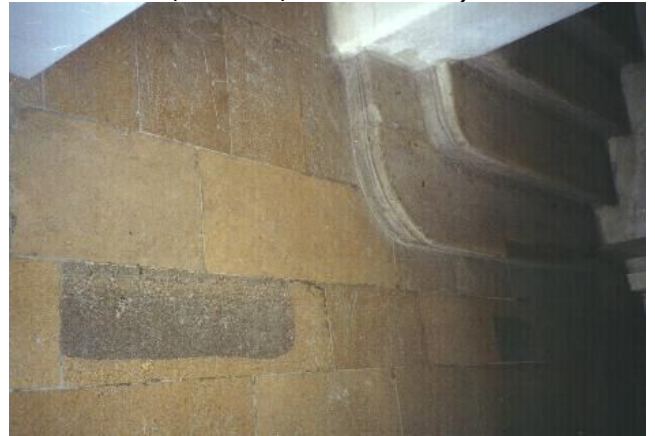
Bodenplatten mit Beginn der Dienststiege,
